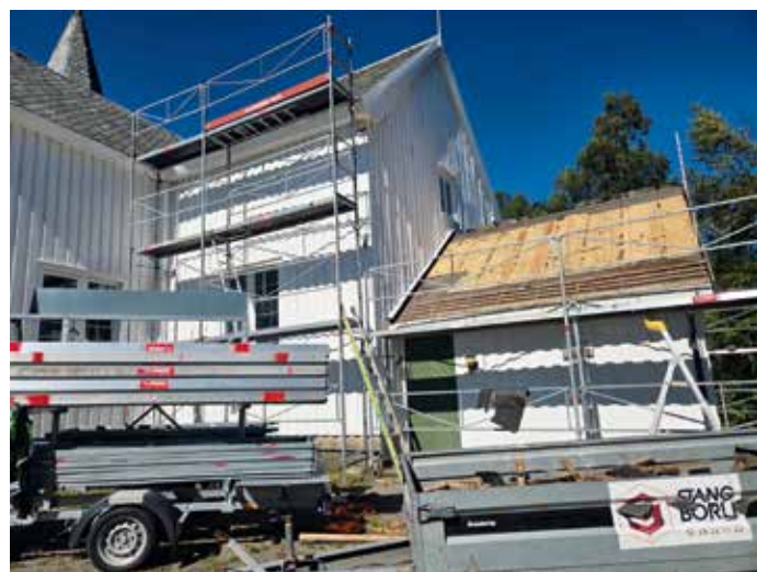
Slik så det ut ved Gyland kirke da takarbeidet ble startet. Skifersteinene på sakristitilbygget t.h. er fjernet og skal brukes på hovedbygget på kirka.
